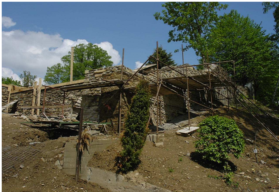
Začátek opravy spadlé zdi.
