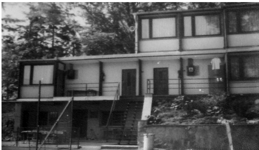
Začátkem 80. let postaveny kabiny, kuchyňka a místnost správce
